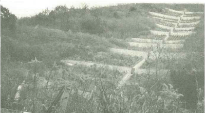
⑦S50 《1975》頃 崩壊地山腹工
